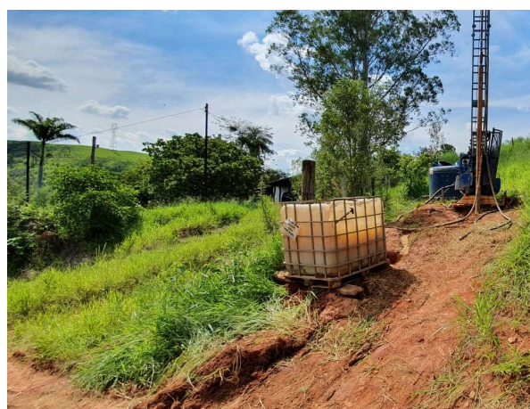
Foto 20: Instalação do poço de monitoramento – PM05 (20/01/2021)
