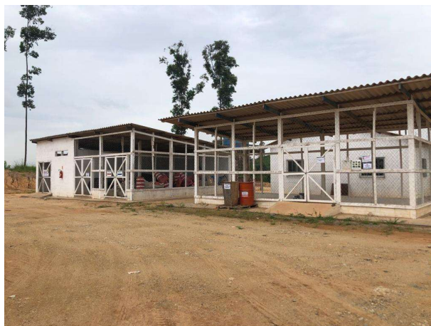
Foto 1: Situação atual das Estruturas no Canteiro operacional (07/04/2021)
