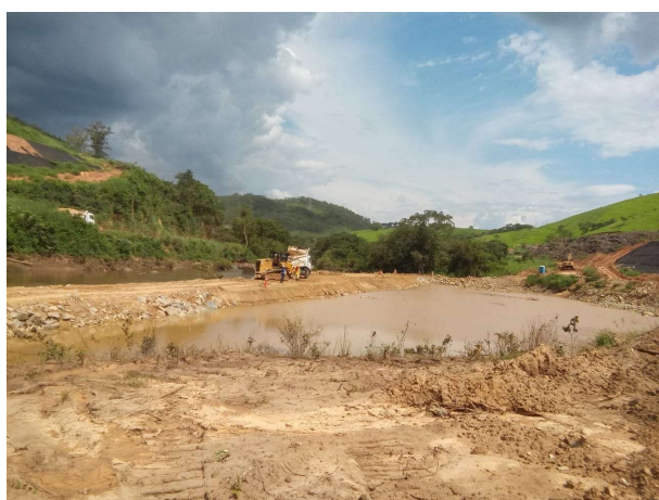
Foto 31: Construção da ensecadeira M0 (31/01/2020)
