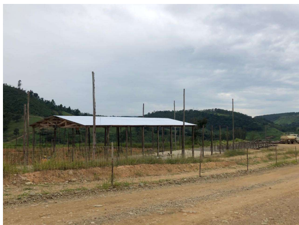
Foto 3: Situação atual das Estruturas no Canteiro operacional (18/03/2021)
