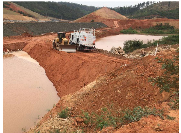
Foto 44: M1a em construção (09/10/2020)
