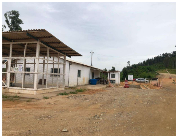
Foto 2: Situação atual das Estruturas no Canteiro operacional (18/03/2021)
