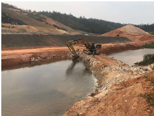
Foto 43: M1 em construção (08/10/2020)
