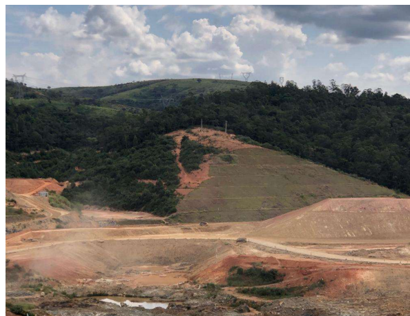
Foto 18: Vista ampliada do eixo da Barragem Pedreira (05/04/2021)
