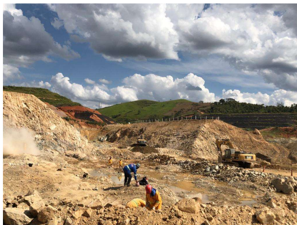
Foto 17: Área da galeria de desvio do Rio Jaguari (05/04/2021)
