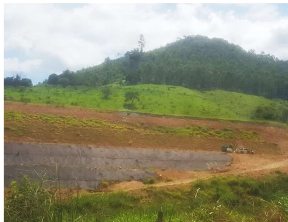
Foto 6: BF 7 Margem direita – aplicação de hidrossemeadura no talude (17/02/2021)
