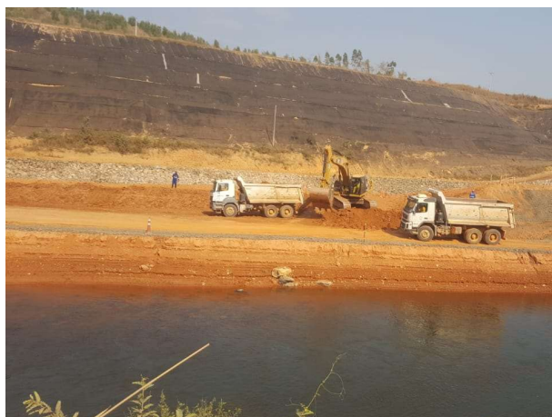
Foto 33: Retirada da ensecadeira M0 (07/10/2020)
