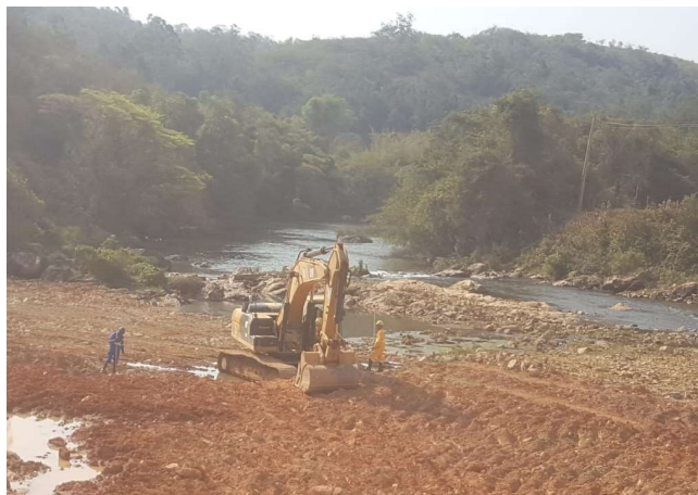
Foto 38: Retirada da ensecadeira J0 finalizada (08/09/2020)
