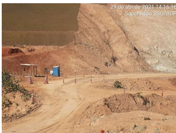
Foto 19: Local próximo a área de desmonte de rocha, na ombeira direita, isolado para execução da atividade (29/04/2021)
