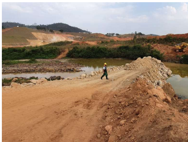
Foto 45: Construção ensecadeira J1 (13/10/2020)
