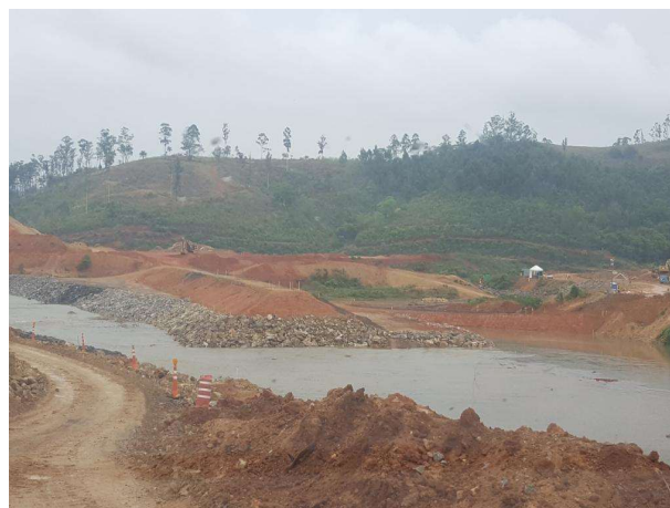
Foto 34: Retirada da ensecadeira M0 finalizada (15/10/2020)
