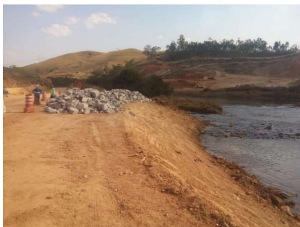
Foto 39: Pré-ensecadeira M1 em construção (30/08/2019)
