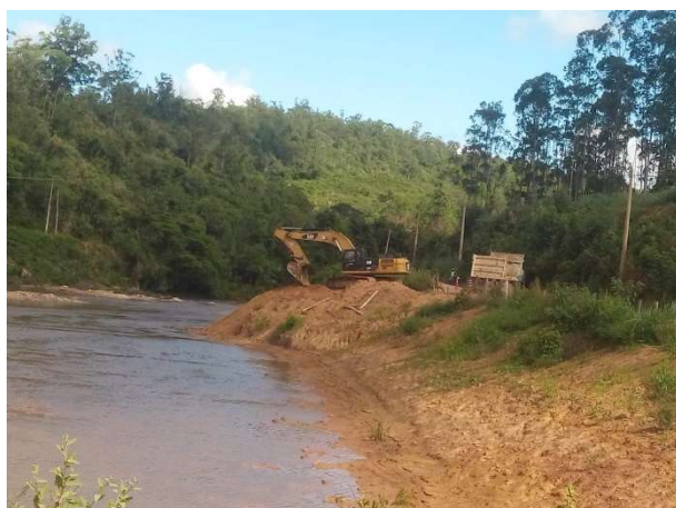
Foto 35: Construção da ensecadeira J0 (29/01/2020)
