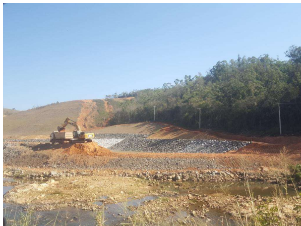
Foto 37: Retirada da ensecadeira J0 (08/09/2020)
