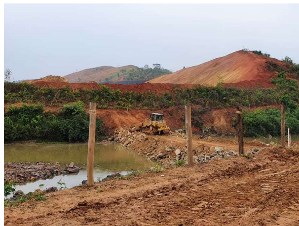
Foto 46: Construção ensecadeira J1 (15/10/2020)
