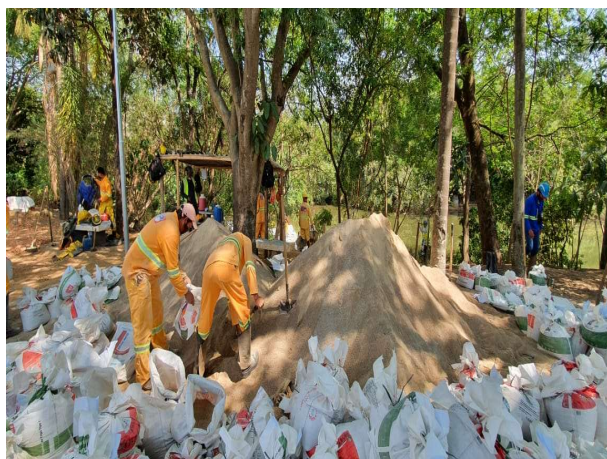
Foto 27: Construção da soleira (05/10/2020)
